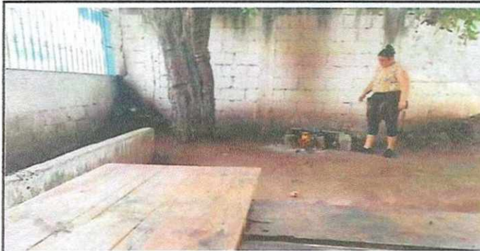
Foto 4: Construcción de estufa tipo rural.
