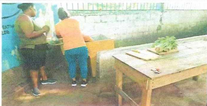
Foto1: reubicación de pila para higienización de alimentos
