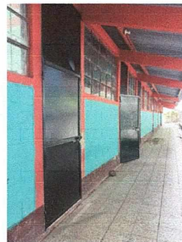
Foto 2: Sustitución de vidrios deteriorados y mantenimiento de vidrios en estructura
