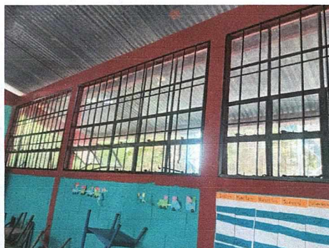
Foto 3: Instalación de balcones
