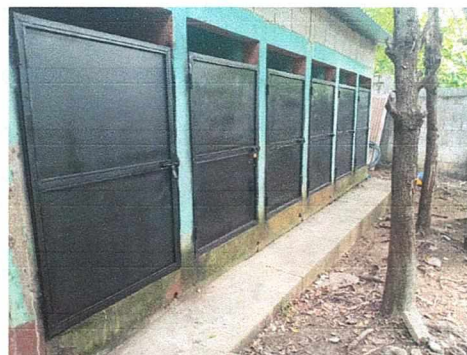
Foto 4: Modulo de baños: mejoramiento de 4 puertas, sustitución de 2 puertas, sustitución de 2 inodoro, instalación de tinaco,
