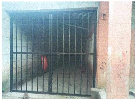
Foto 5: Construcción de bodega: levantado de muro, instalación de techo, fundición de contrapiso, instalación de puerta.
