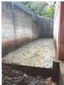
Foto 5: Construcción de bodega: levantado de muro, instalación de techo, fundicion de contrapiso, instalacion de puerta.
