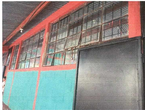
Foto 2: Sustitución vidrios deteriorados y mantenimiento de vidrios en estructura
