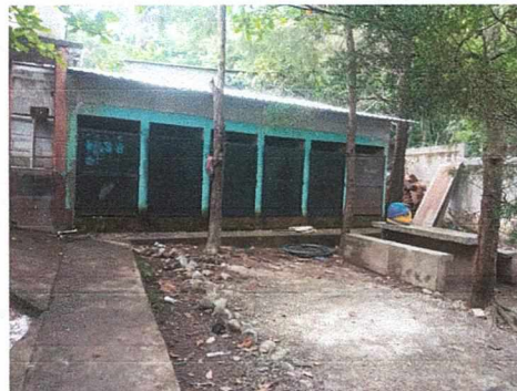
Foto 4: Modulo de baños: mejoramiento de 4 puertas, sustitucion de 2 puertas, sustitución de 2 inodoro, instalación de tinaco,
