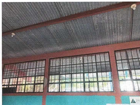
Foto 3: Instalación de balcones
