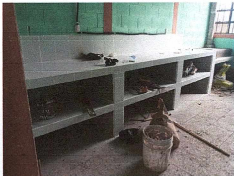
Foto 1: Construcción de estufa rural con chimenea y mueble bajo fundido, instalación de pila con instalación de agua y drenaje
