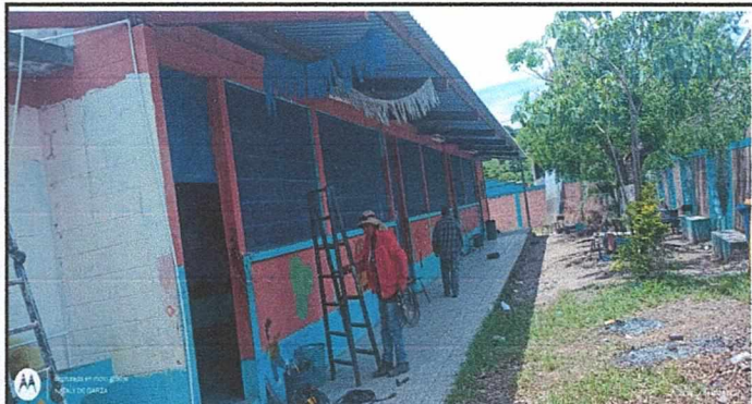
Foto 2: VENTANALES DE MALLA
