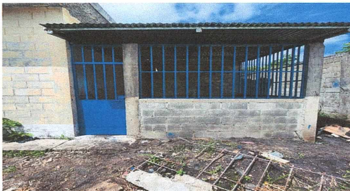
Foto 4: CONSTRUCCIÓN DE COCINA
