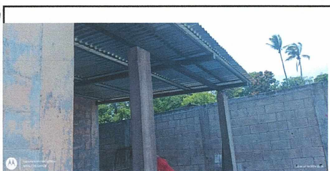
Foto 5: TECHADO DE COCINA NUEVA
