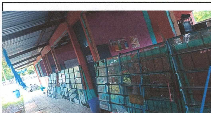
Foto 3: DESMONTADO DE LAS VENTANAS DE VIDRIO
