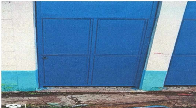
Foto 6: REPARACIÓN DE PUERTAS DEL BAÑO
