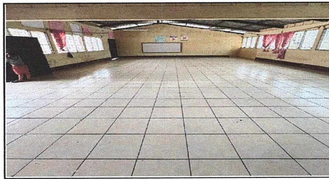
Foto 6: Instalación de piso cerámico en aulas.
