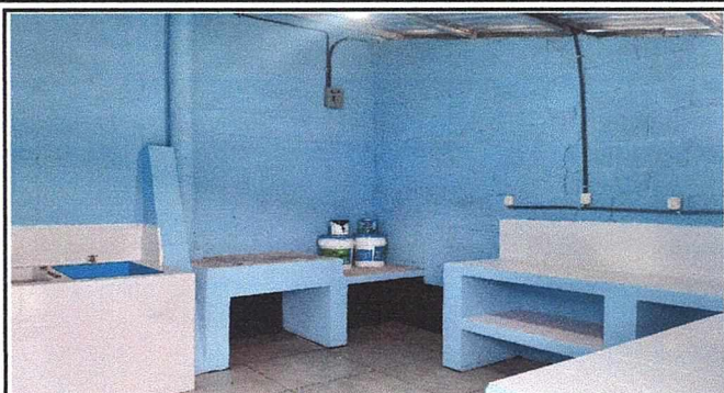
Foto1: Reparación del sistema eléctrico, construcción de pila de concreto e instalación de azulejo, construcción de mueble bajo e instalación de azulejo, instalación de piso cerámico, pintura en muros y mejoramiento de
