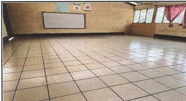
Foto 4: Instalación de piso cerámico en aula
