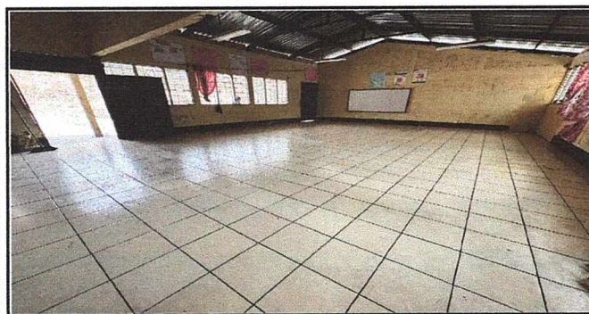
Foto 5: Instalación de piso cerámico en aulas
