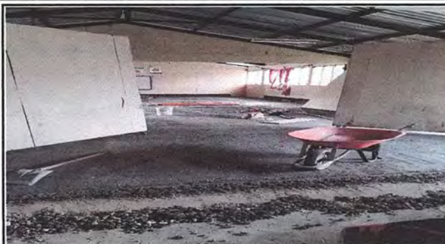
Foto 2: Contrapiso de concreto de 0.07m
