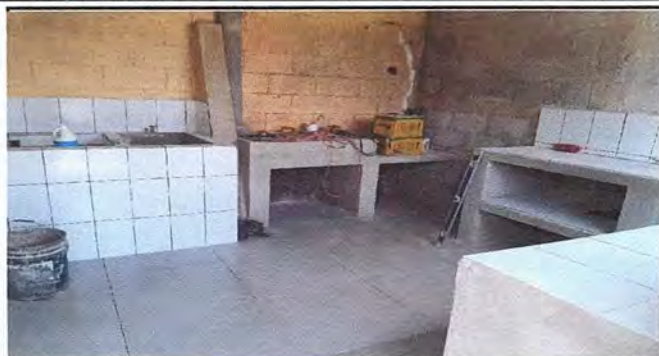
Foto1: Colocación de azulejo en pila, en mueble bajo y en pared. Colocación de piso cerámico en cocina.
