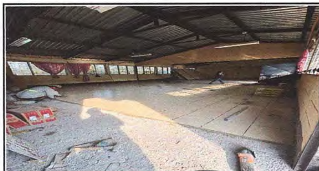
Foto 3: Colocación de piso cerámico en aula
