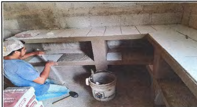
Foto 4: Colocación de azulejo en mueble bajo.
