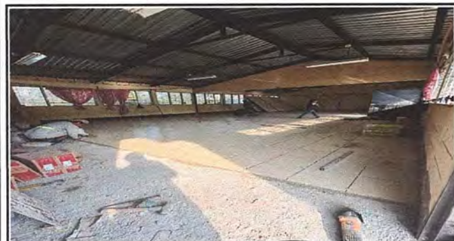
Foto 3: Colocación de piso cerámico en aula
