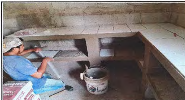
Foto 4: Colocación de azulejo en mueble bajo.
