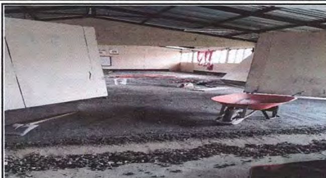
Foto 2: Contrapiso de concreto de 0.07m
