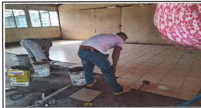
Foto 6: Colocación de piso cerámico en aula.
