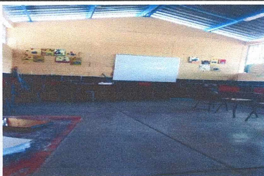
Foto 3: Limpieza de Aulas para pintar
