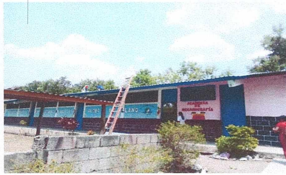
Foto 2: Instalación de lamina nueva
