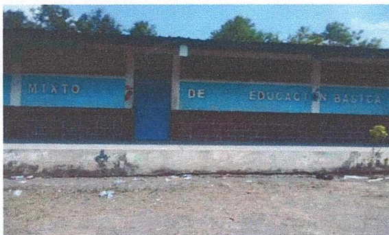
Foto 5: Pintado de puertas de Aulas
