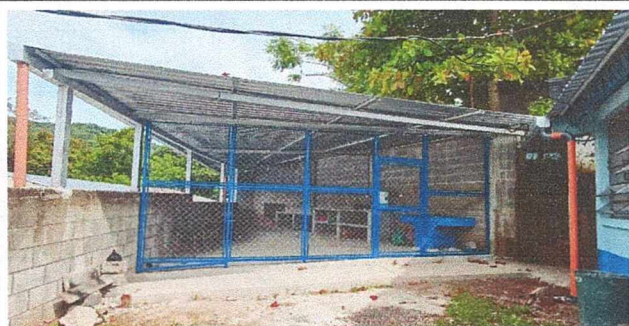
Foto 7: Continuar levantado de circulación, instalación de techo y estructura metálica, fundición de contrapiso, construcción estufa rural con chimenea, instalación de pila, instalación eléctrica y cerramiento con malla.
