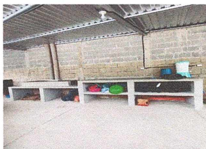
Foto 8: Continuar levantado de circulación, instalación de techo y estructura metálica, fundición de contrapiso, construcción estufa rural con chimenea, instalación de pila, instalación eléctrica y cerramiento con malla.
