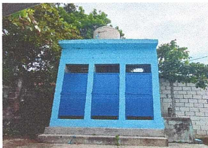
Foto 5: Pintura general, mantenimiento de puertas, mejoramiento instalación de tinaco y accesorios.
