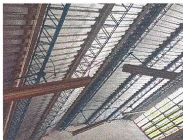
Foto 1: Sustitución de techo y estructura metálica.
