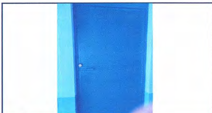
Foto 9: Mantenimiento de puertas
