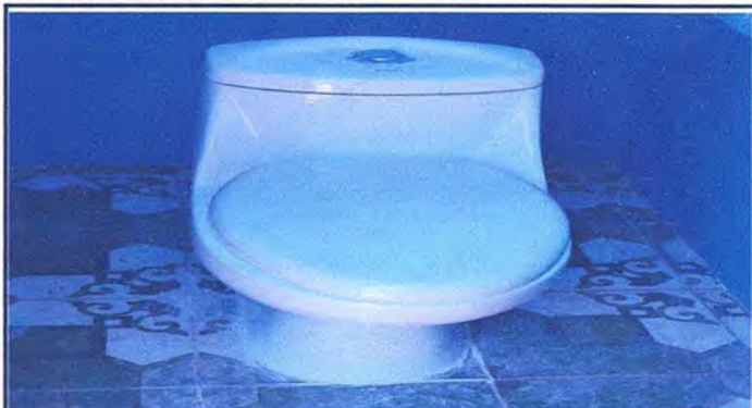
Foto1: Sustitucion de Inodoros
