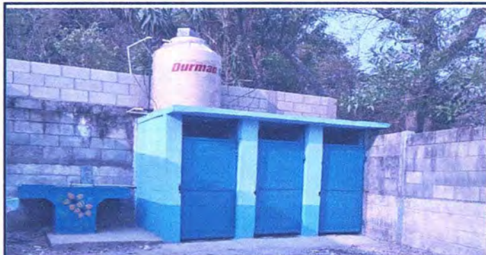
Foto 7: Instalación de tinaco
