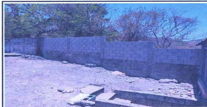
Foto 6: Levantado de muros y fundición de columnas
