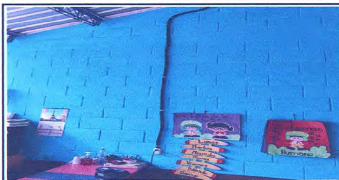
Foto 12: Mejoramiento de sistema eléctrico
