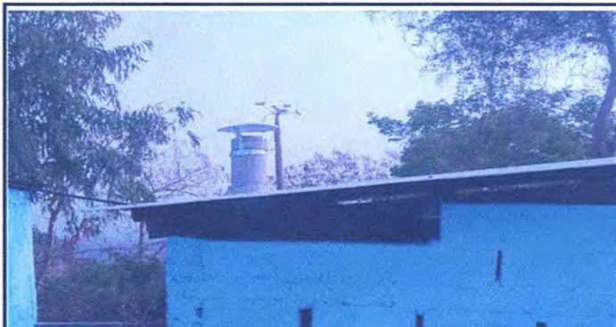
Foto 8: Instalación de Chimenea
