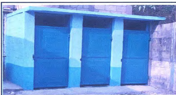
Foto 10: Sustitución de puertas metálicas de sanitarios
