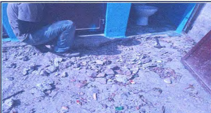
Foto1: Sustitucion de Inodoros
