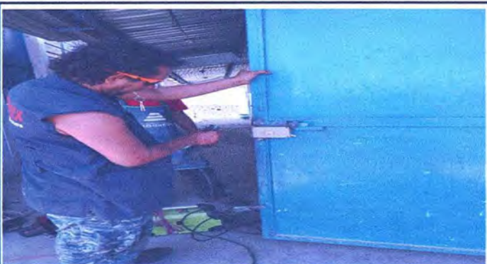
Foto 9: Mantenimiento de puertas
