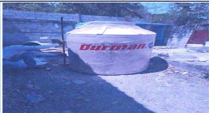
Foto7: Instalación de tinaco
