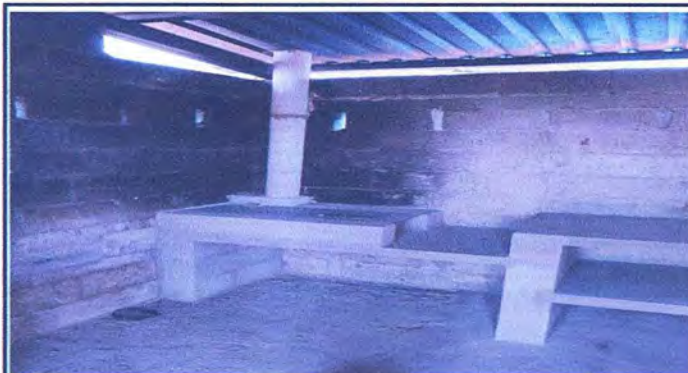
Foto 8: Instalación de Chimenea
