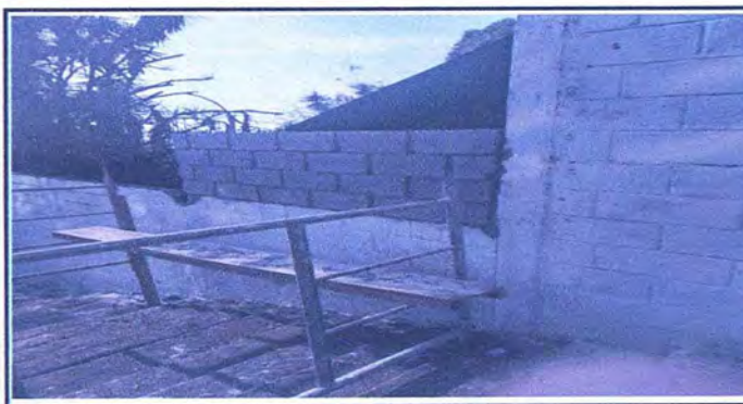
Foto 6: Levantado de muros y fundición de columnas
