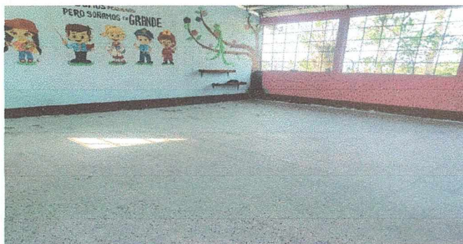
Foto1: sustitución de torta lisa por piso de granito en aulas
