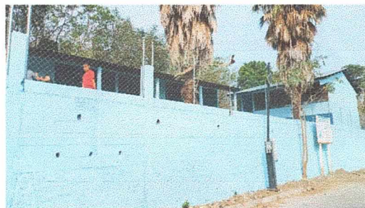
Foto 2: Mejoramiento de la pintura del muro frontal.
