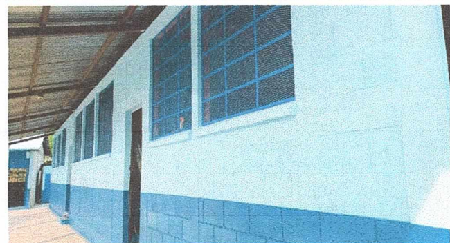
Foto 3: Sustitución de balcones en mal estado
