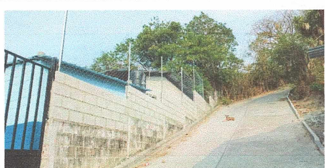
Foto 6: Mejoramiento del muro perimetral con block y malla metálica.
