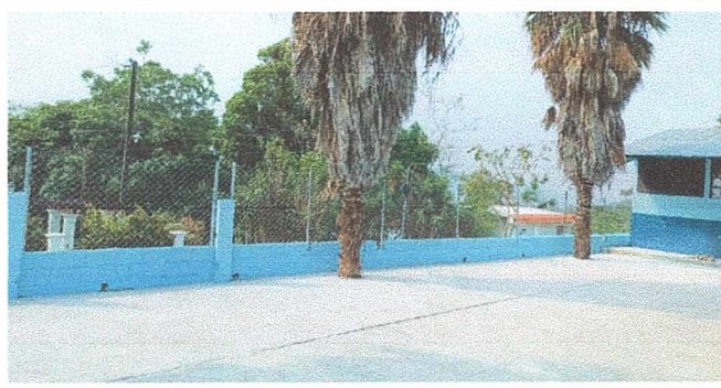
Foto 4: Sustitución de malla metálica
