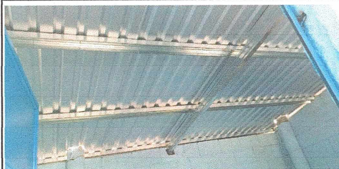
Foto 5: Sustitución del techo de la cocina
