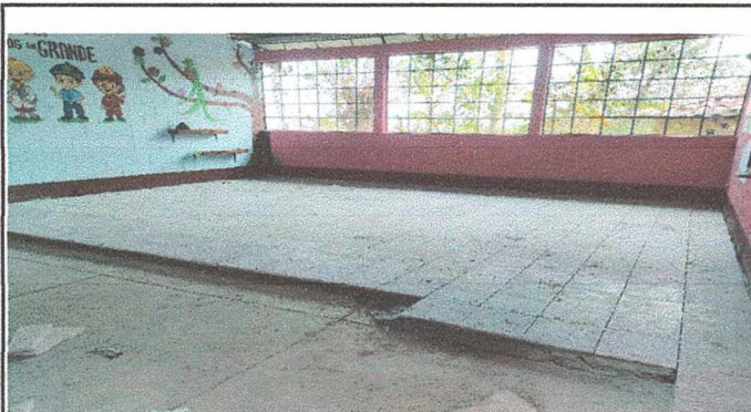
Foto1: sustitución de torta lisa por piso de granito en aulas
