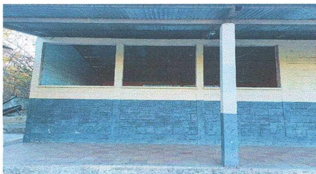
Foto 3: Sustitución de balcones en mal estado
