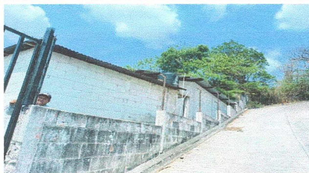
Foto 4: Sustitución de malla metálica
