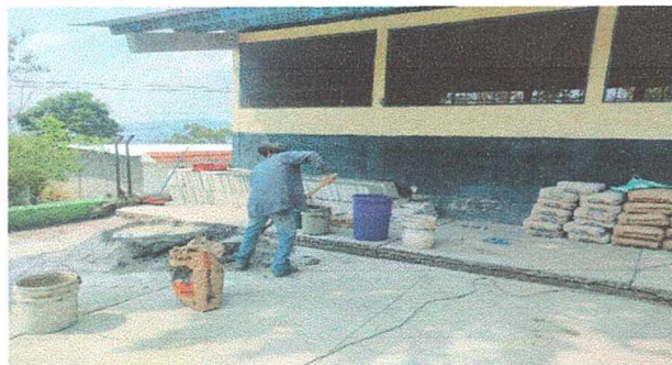
Foto 6: Mejoramiento del muro perimetral con block y malla metálica.
