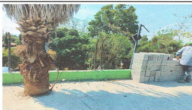
Foto 2: Mejoramiento de la pintura del muro frontal.
