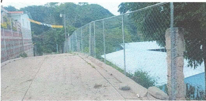
FOT: 3. Malla perimetral colocada
