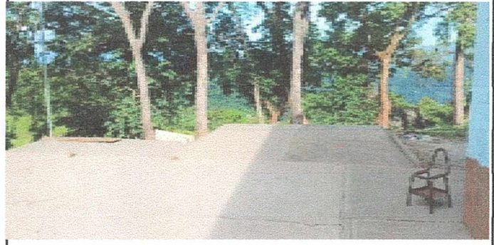
Foto 2: Area de fundicion de torta terminada
