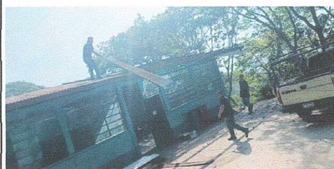
Foto1: RETIRANDO TECHO PARA RESTUARLO
