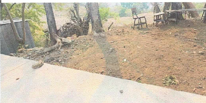
FOTO: Preparando terreno para fundir
