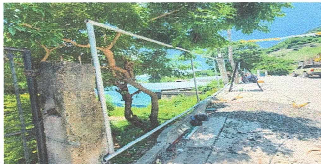
Foto 2: Preparando para colocacion de malla perimetral
