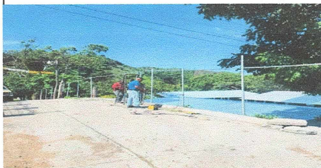
Foto 4: para colocar malla perimetral
