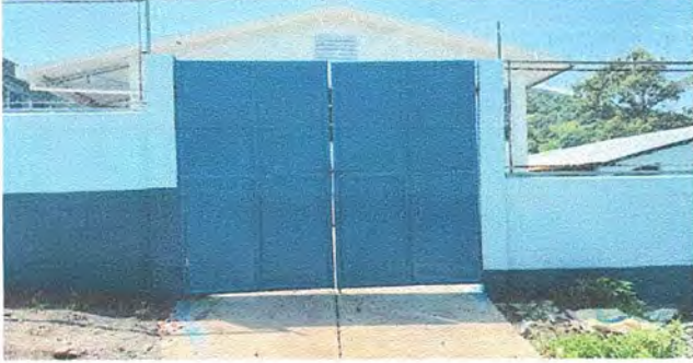
Foto. 1 finalizacion de mejoramiento de porton de malla a lamina de 2.50 x 3.04
