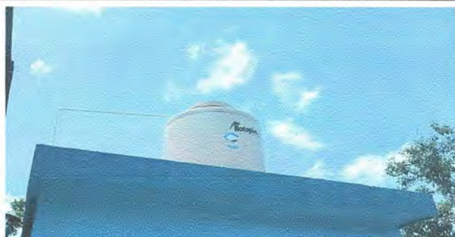
Foto 2. instalacion de tinaco existente y accesorios finalizada
