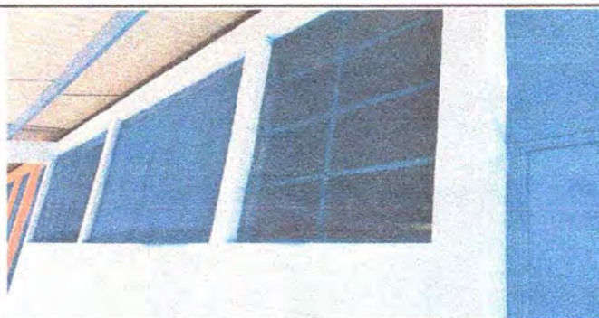
Foto 6: finalizacion pintura de maya de ventanas
