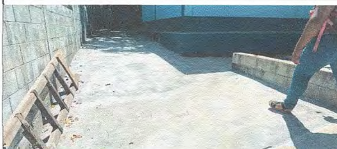
Foto 1 finalizacion de piso de concreto
