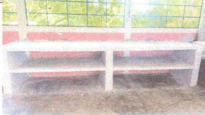
Foto 2: Finalizado Gabinete de Cocina
