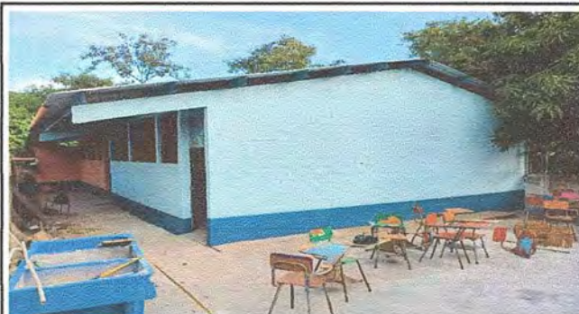
foto 4.finalizacion de pintura de paredes de frente de las aulas
