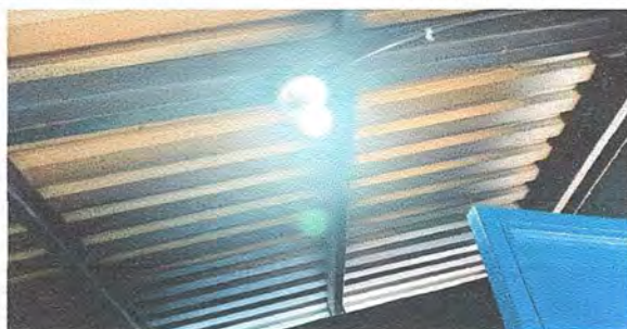
Foto 3; instalacion de luz electrica
