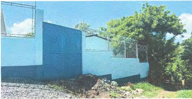
Foto 3: Finalizacion de mejoramiento de porton de malla a lamina de 2.50 x 2.00
