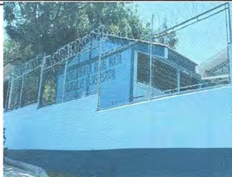
foto 2 en proceso instalacion alambre de cuchillas (rason)
