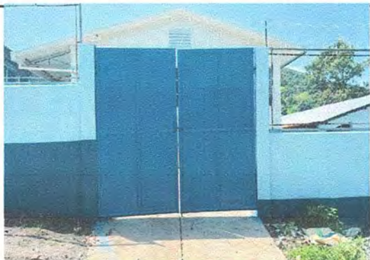
en proceso de mejoramiento de porton de malla a lamina
