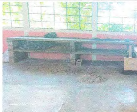
foto 1 en proceso de la elaboracion de gabinete de concreto
