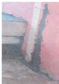
foto 2 en proceso de instalacion e agua potable
