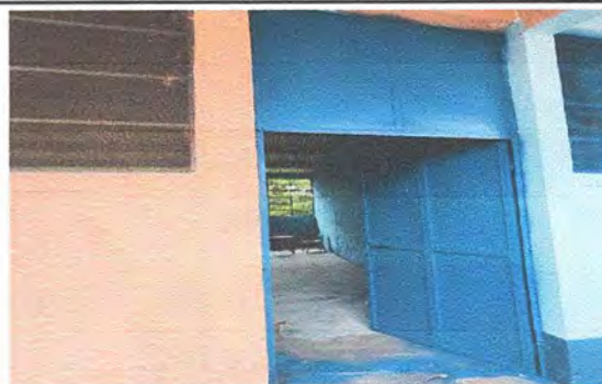
foto 6 en proceso pintura de ventana de malla
