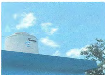
foto 3 en proceso de instalqacion de tinaco existente con accesorios
