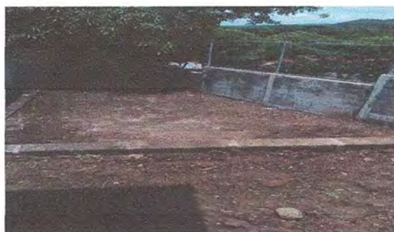
foto 3 en proceso de fundicion de piso de cemento o torta de cemento
