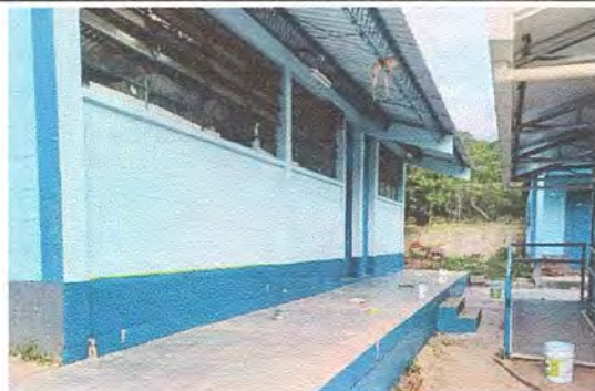
foto 4 en proceso de pintura de paredes exteriores
