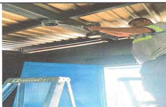
foto 6: en proceso de mejoramiento e instalacion de luz.
