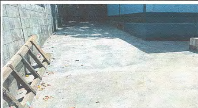
Foto 4: proceso de losa de patio
