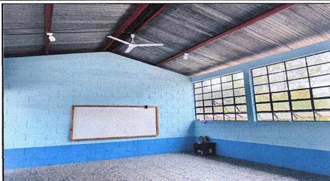
Foto 2: Mejoramiento de aula, con pintura y sistema eléctrico.
