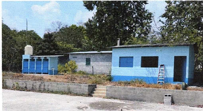
Foto 4: Baños y cocina mejorada.
