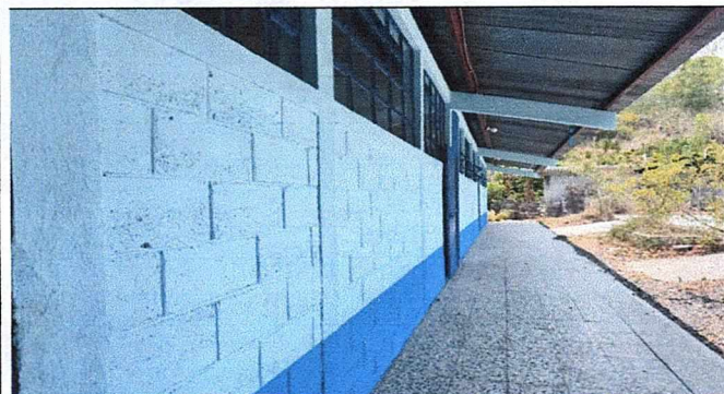
Foto 3: Pintura y vidrios mejorados.
