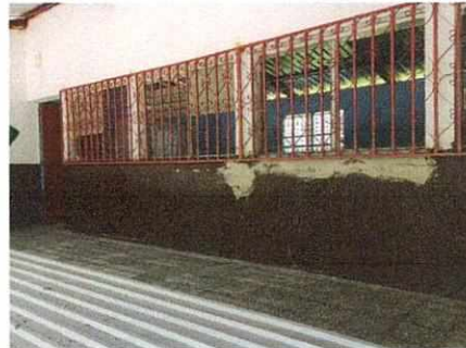
MANTENIMIENTO DE PINTURA BALCONES
