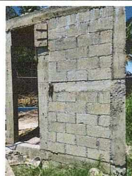
REFORZAMIENTO DE PAREDES PARA TERRAZA SANITARIOS
