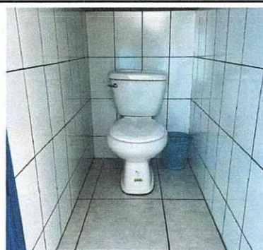
CAMBIO DE SANITARIOS
