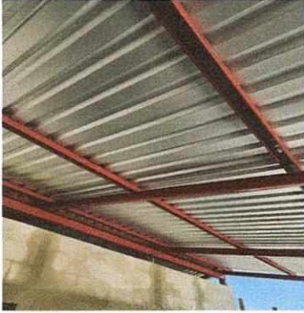
CAMBIO DE LÁMINAS DE TECHO
