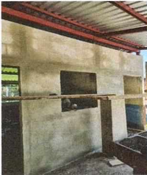
REMODELACIÓN PARA AREA DE COCINA
