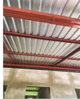
CAMBIO DE LÁMINAS DE TECHO
