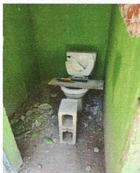
CAMBIO DE SANITARIOS
