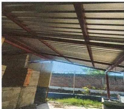
SUSTITUCIÓN DE LÁMINAS
