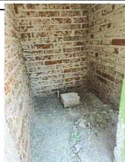
CAMBIO DE SANITARIOS
