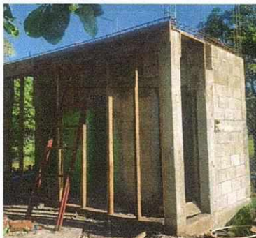
REMEDIACIÓN DE BAÑOS
