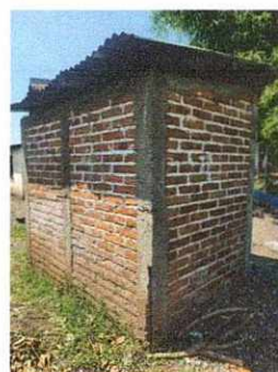
REFORZAMIENTO DE PAREDES PARA TERRAZA
