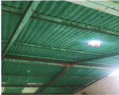
CAMBIO DE LÁMINAS DE TECHO
