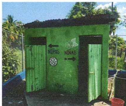
CAMBIO DE PUERTAS A SANITARIOS
