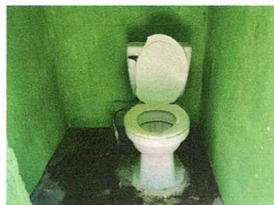
CAMBIO DE SANITARIOS
