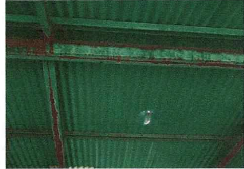
CAMBIO DE LÁMINAS DE TECHO
