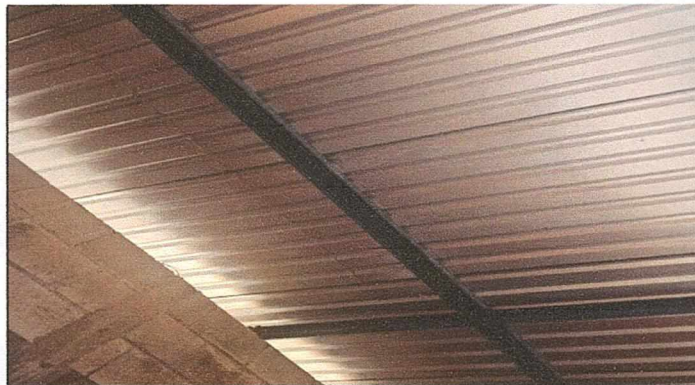
Foto 4: REPARACION AREA DE DIRTECCION
