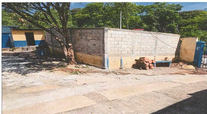
Foto 3: REPARACION DEL MURO PERIMETRAL
