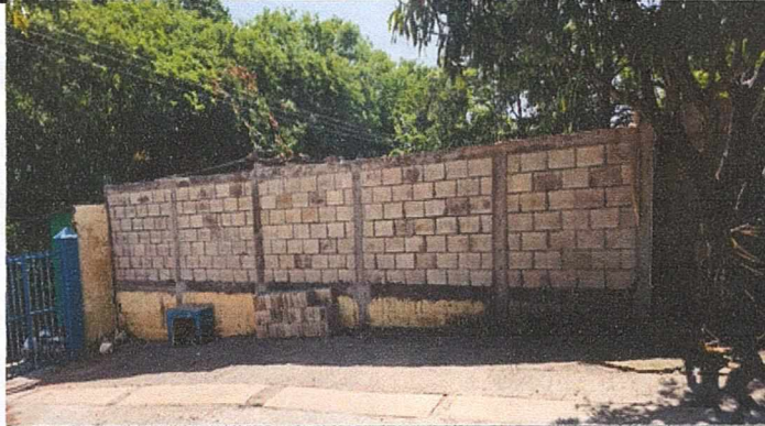
Foto 2: REPARACION DE MURO PERIMETRAL
