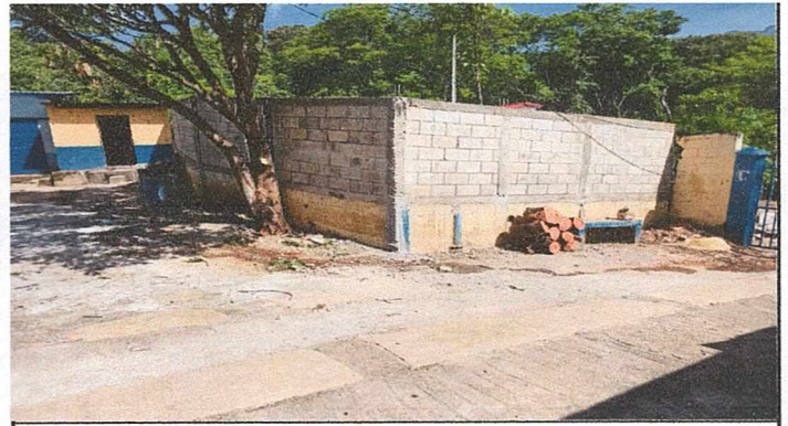
Foto 4: REPARACION DE MURO PERIMETRAL
