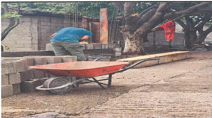
Foto 3: REPARACION DEL MURO PERIMETRAL
