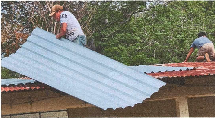
Foto1: REPARACION DEL TECHO
