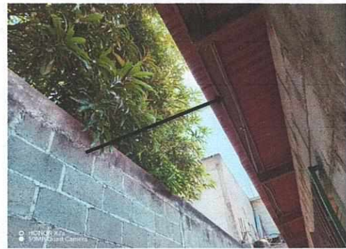
Foto 8: Renglón 17. Reparación de sistema Eléctrico
