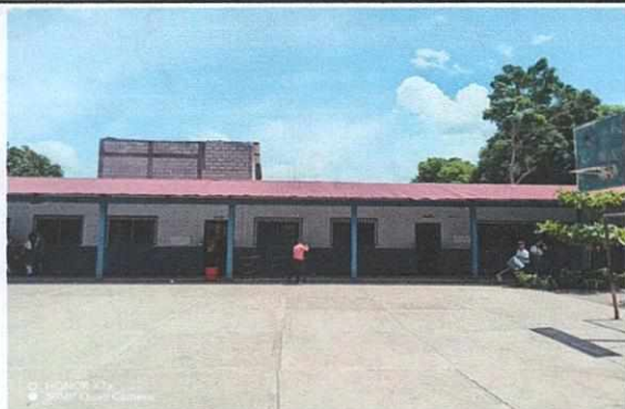
Foto 1: Renglón 1: Cubierta de lámina.
