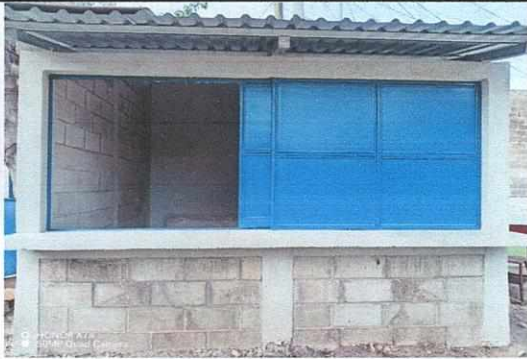
Foto 9: Renglón 20. Reparación de área para cocina
