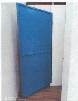
Foto 3: Renglón 4: Puertas (sustitución de puertas)
