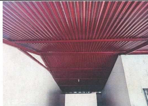
Foto 2: Renglón 2: Estructura de techo.
