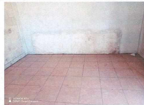
Foto 6: Renglón 6.2 Instalación de piso cerámico en cocina
