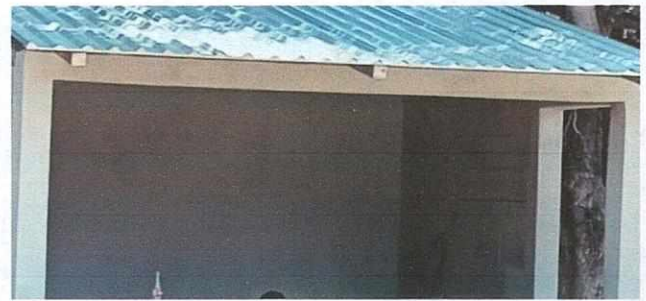
Foto 10: Renglón 21. Reparación de repello y cernido
