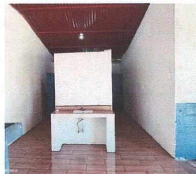
Foto 4: Renglón 6: Piso 4.1 Instalación de piso cerámico
