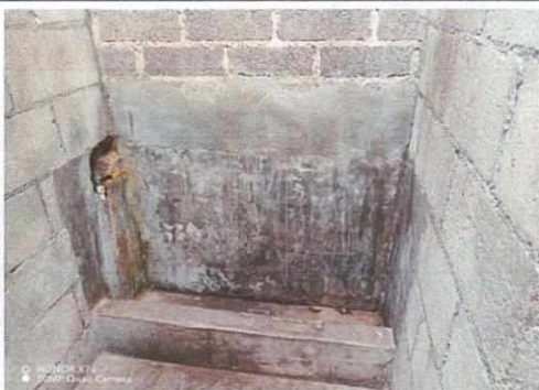
Foto 5: Renglón 10: Servicios sanitarios
