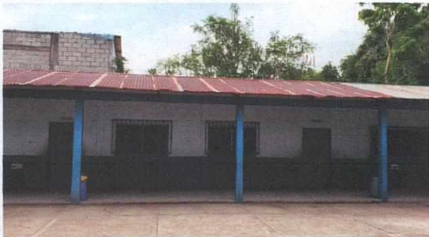
Foto 1: Renglón 1: Cubierta de lámina.
