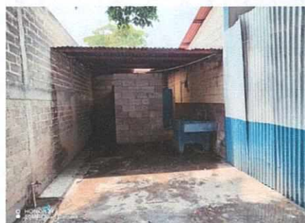
Foto 4: Renglón 6: Piso 4.1 Instalación de piso cerámico
