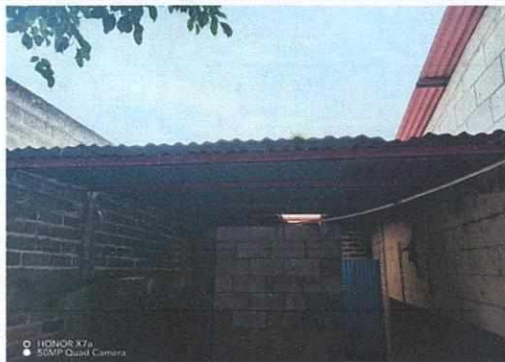
Foto 2: Renglón 2: Estructura de techo.
