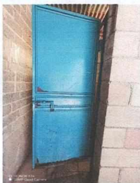
Foto 3: Renglón 4: Puertas (sustitución de puertas)
