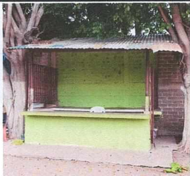
Foto 9: Renglón 20. Reparación de área para cocina
