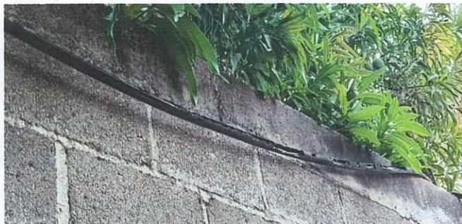
Foto 8: Renglón 17. Reparación de sistema Eléctrico
