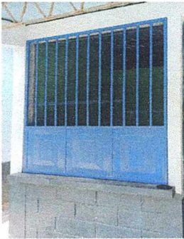
Foto1: Mantenimiento a estructura de metal de ventana
