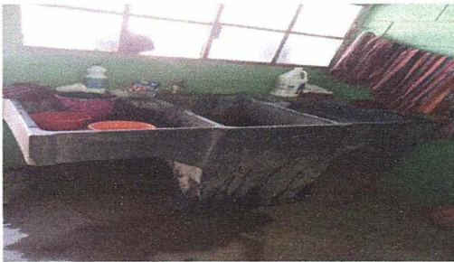
Foto 3: Reparación de pila de cemento de dos lavaderos
