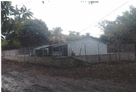
Foto 5: Sustitución de Muro perimetral de block
