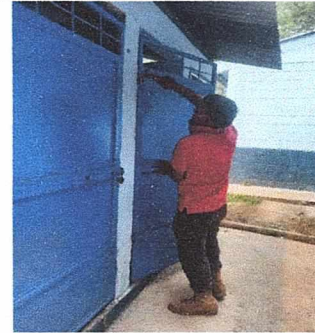
Foto 2: Sustitución de puertas de metal en servicios sanitarios
