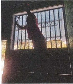
Foto 1: Mantenimiento a estructura de metal de ventana
