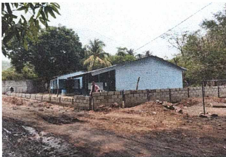
Foto 5: Sustitución de Muro perimetral de block
