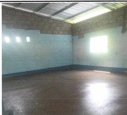
Foto 5: se amplió las paredes del aula, se instaló el techo, se ampliaron las ventanas y cambio de piso de cemento.
