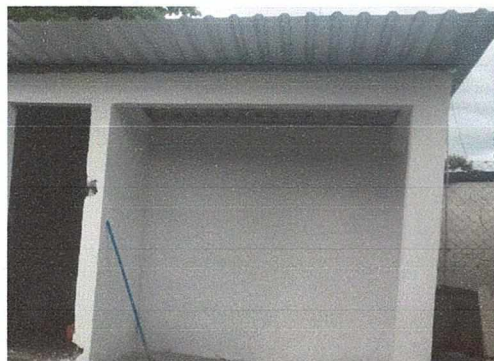
Foto 2: Se cambió la pila por una nueva, se renovó el piso de cemento y se ampliaron los espacios de los sanitarios.
