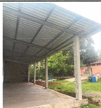
Foto 4: Se ampliaron las ventanas y cambiaron puertas, se colocó piso de cemento, ampliación de aulas y corredor, cambio de techo.
