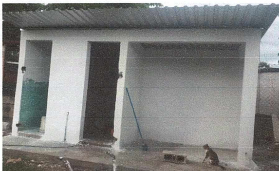
Foto 3: se instalaron sanitarios, puertas y piso antideslizante.
