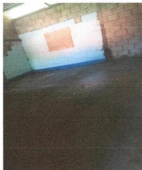
Foto 6: En el aula 2 realizó entortado de piso de cemento, se agregó altura y ancho a las paredes, se cambió el tamaño y posición de la ventana y se cambió el techo con estructura y lámina.
