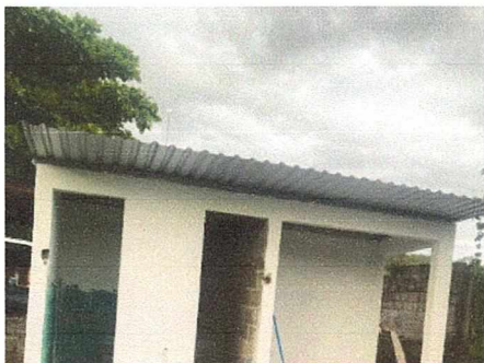
Foto 1: se cambió el techo con estructura y lámina a los sanitarios, se agregó altura a las paredes, se repellaron, se cambiaron las puertas y e inodoros.
