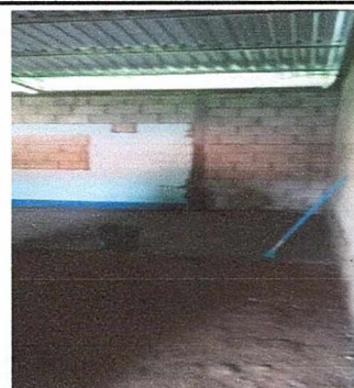
Foto 6: En el aula 2, se inició con la colocación del entortado de piso de cemento, se le agregó altura y ancho a las paredes del aula, se cambió techo.
