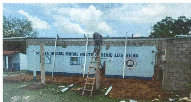
Foto 4: se realizó la ampliación de paredes de las aulas, se rellenó el suelo con selecto, para poder entortar, se está realizando la instalación del techo con estructura y lámina.
