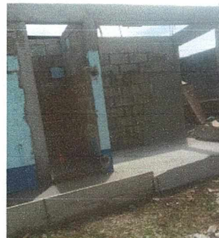
Foto 2: Se removió la letrina de cemento, se están reforzando las paredes, vigas y pilares con hierro y concreto, se realiza una ampliación de ancho y altura de entortado de cemento en los sanitarios
