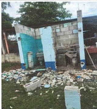
Foto 1: Se quitó el techo, se está subiendo el tamaño de las paredes, ampliación de espacio dentro de los sanitarios y remoción de letrinas y puertas en mal estado.
