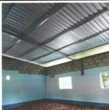
Foto 5: Se amplió las paredes de el aula 1, se instaló el techo luego se ampliaron las ventanas y se hará piso de cemento.
