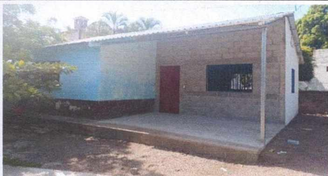
Foto 1: REPARACION DE BODEGA
