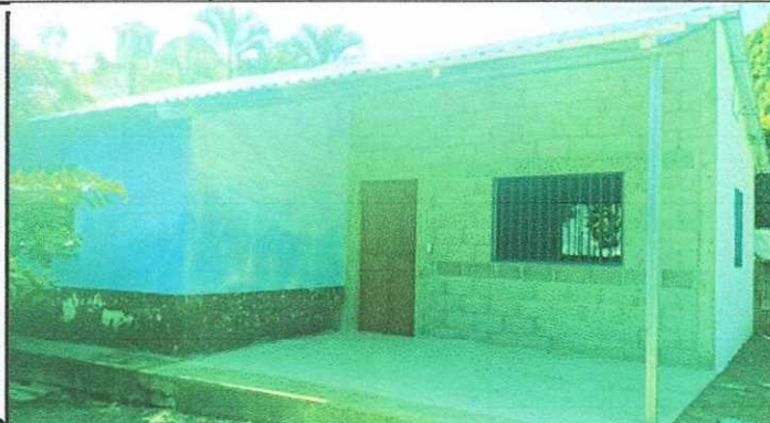
Foto 1: REPARACION DE BODEGA
