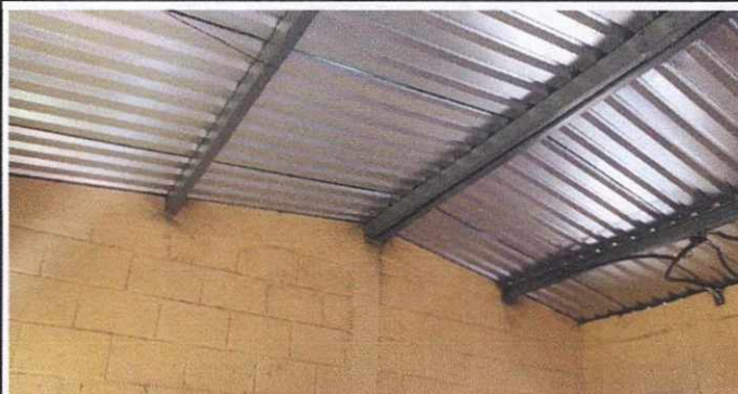
Foto 2:REPARACION DE TECHO
