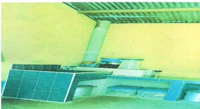
Foto 3: REPARACION DE COCINA
