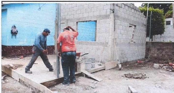
Foto 3: REPARACIÓN DE BODEGA
