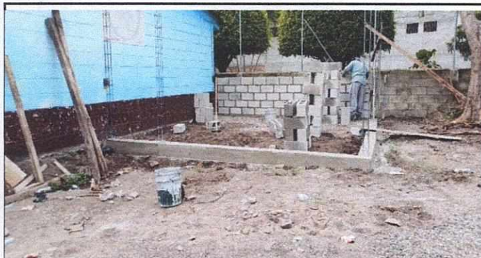
Foto 1: REPARACION DE BODEGA
