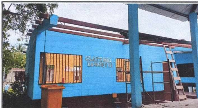
Foto 2: REPARACION DE TECHO
