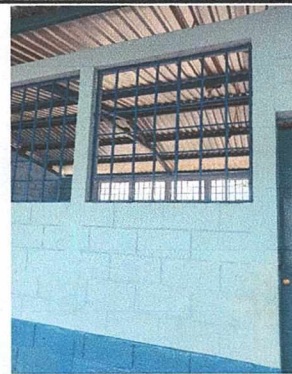
Foto 4: Reforzamiento de estructura metálica y pintura de ventanas.
