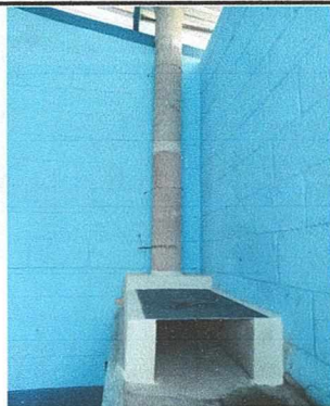
Foto 3: Cambio de plancha e instalación de chimenea.
