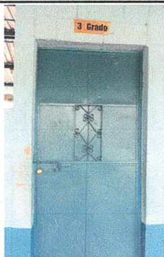
Foto 1: Instalación de chapa en puerta de metal.
