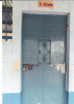
Foto 6: Instalación correcta de puerta + chapa.
