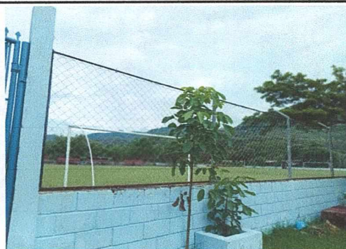
Foto 5: Instalación y reforzamiento de cerco con malla en muro perimetral.
