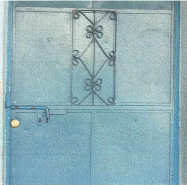
Foto 1: Instalación de chapa en puerta de metal.
