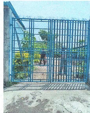
Foto 2: Mejoramiento y reforzamiento de portón metálico.
