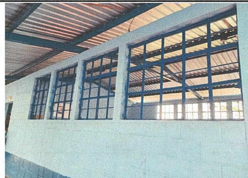
Foto 6: Sustitución de vidrio y reforzamiento por estructura metálica y pintura de las ventanas.
