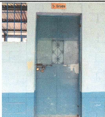
Foto 3: Instalación correcta de puerta + chapa.
