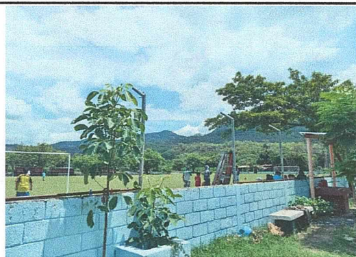
Foto 4: Instalación y reforzamiento de cerco con malla en muro perimetral.
