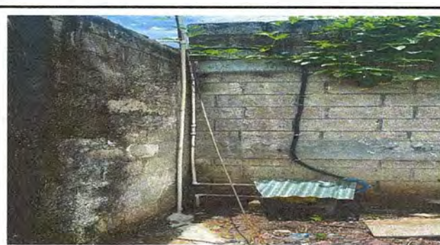
Foto # 6: Se cambio el drenaje hacia el agua potable, para llenar recipientes
