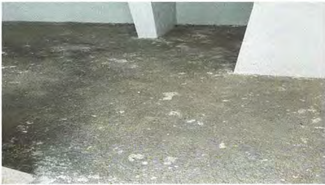
Foto # 7 Se cambio la losa de patio a concreto.
