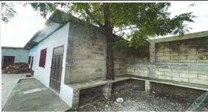
Foto # 9 Se realizo la pared de cocina.
