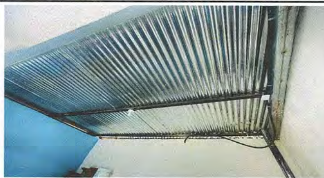
Foto # 2 se cambiaron las costaneras metalicas
