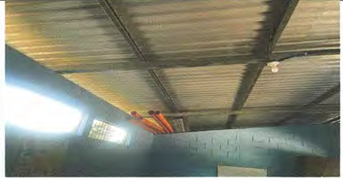
Foto # 8 Se cambio todo el cableado de la electricidad, juntamente con interruptores y tomacorrientes
