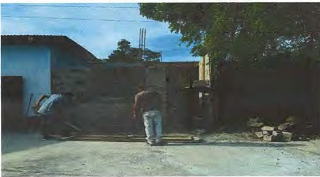
Foto # 9 Se realizo la pared de cocina.
