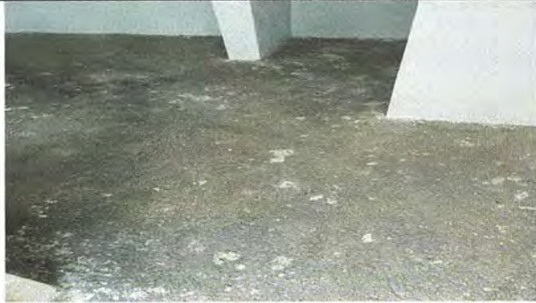
Foto# 7 losa de patio a concreto.
