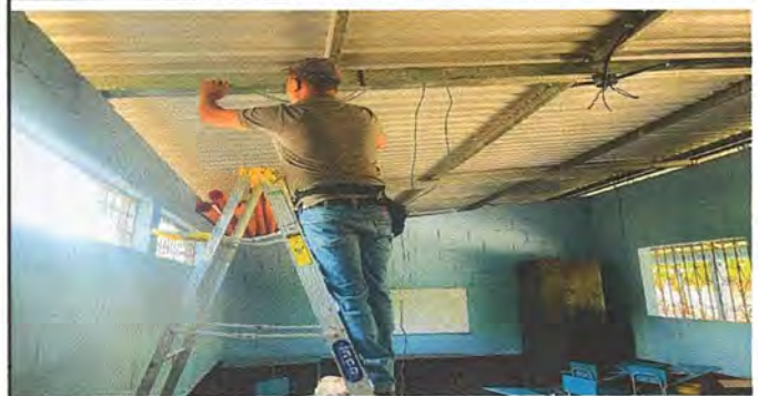
Foto # 8 Reparacion de sistema electrico
