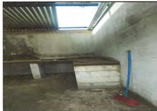
Foto # 2 se cambiaron las costaneras metalicas
