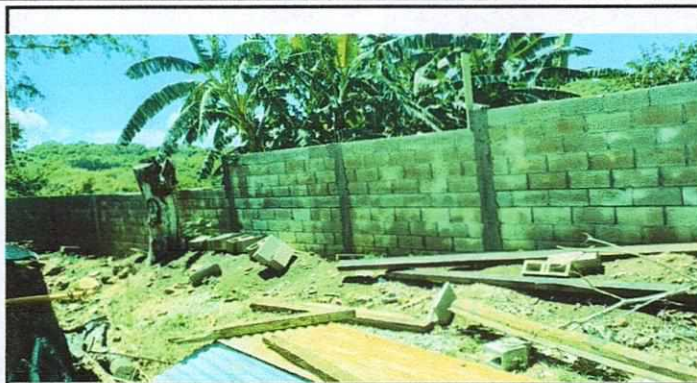
Foto 2: REPARACION DE MURO PERIMETRAL
