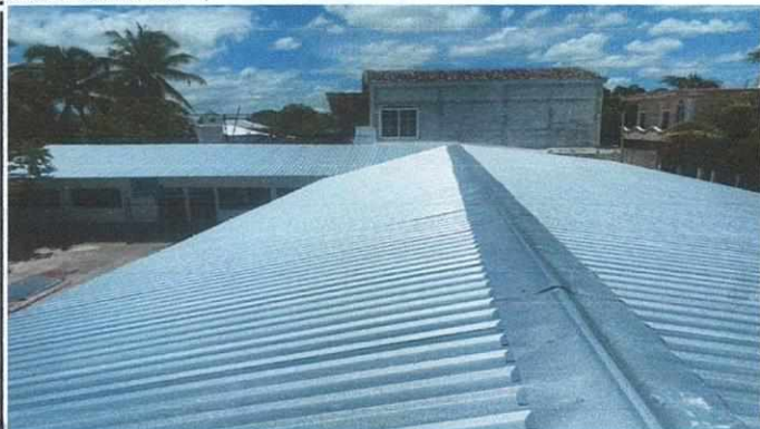
Foto 1. Techo. Cambio de techo en las aulas
