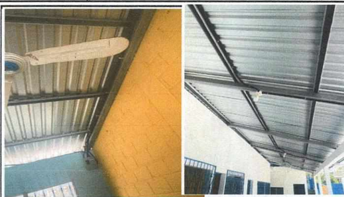
Foto 2. Reparacion de sistema Electrico. Se cambiara todo lo electrico
