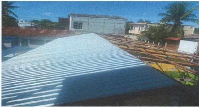
Foto 1. Techo. Cambio de techo en las aulas
