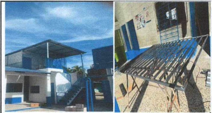
Foto 4 Mantenimiento a barrandas y finalizacion
