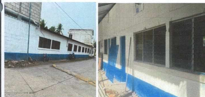
Foto 5: Ventanas: mantenimiento de pintura en ventanales internos y externos
