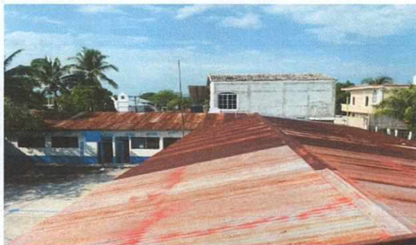
foto 1. Techo. Cambio de techo en las aulas
