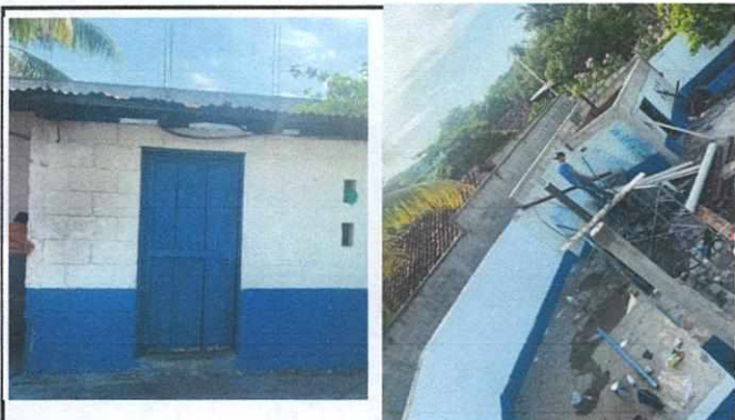
foto 3. Reparacion o Sustitucion de puerta en cocina. Puerta en mal estado se cambia por una con chapa. Y se remodelara la cocina
