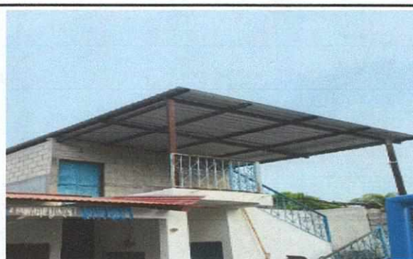
foto 4. Mantenimiento a barrandas y finalizacion
