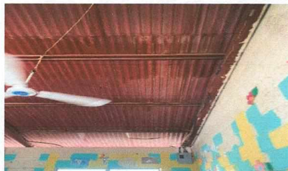
foto 2. Reparacion de sistema Electrico. Se cambiara todo lo electrico
