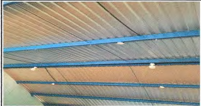
Foto 2: Reparación de sistema eléctrico.
