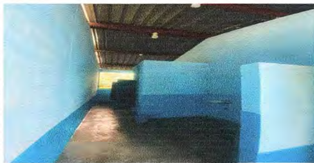
Foto 5: Pintura en muros interior y exterior
