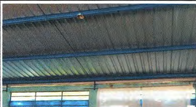
Foto 8: Estructura de techo
