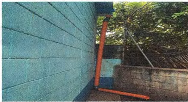
Foto 3: Canales y bajadas de agua pluvial.
