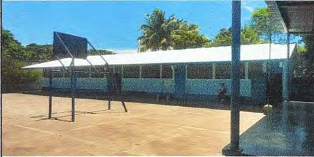
Foto 1: Cubierta de lámina.
