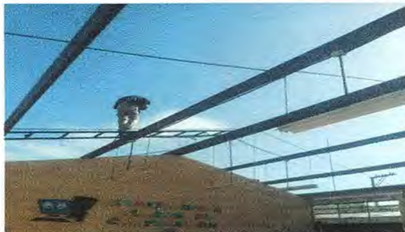
Foto 8: Estructura de techo
