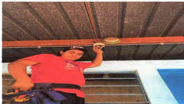
Foto 2: Reparación de sistema eléctrico.
