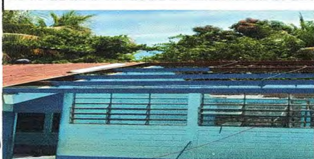
Foto 1: Cubierta de lámina.
