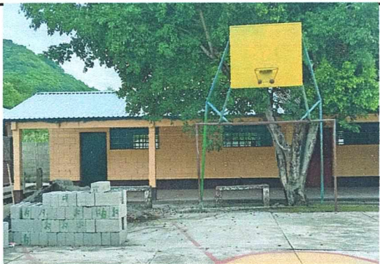
Foto 1: Cambio de techo y pintura del mismo.
