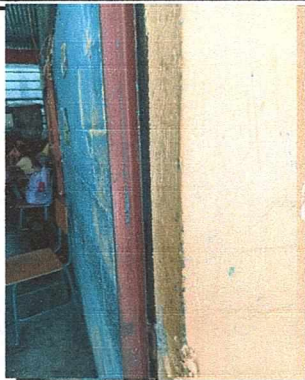
Foto 7: Reparación de puertas.
