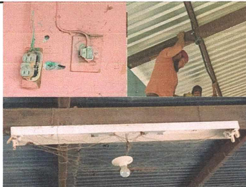
Foto 4: Reparación del sistema eléctrico.
