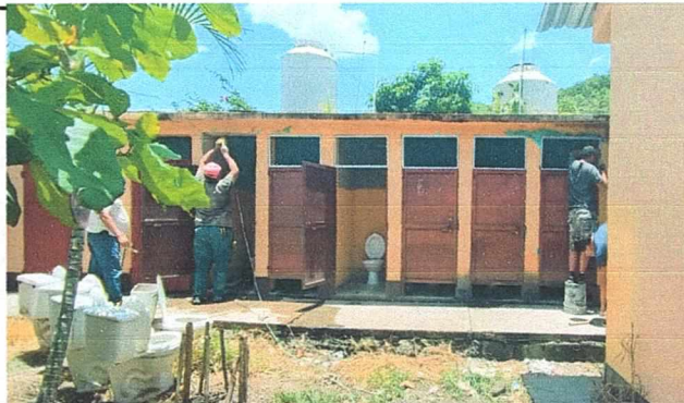
Foto 6: Instalación de ventanas de cedazo
