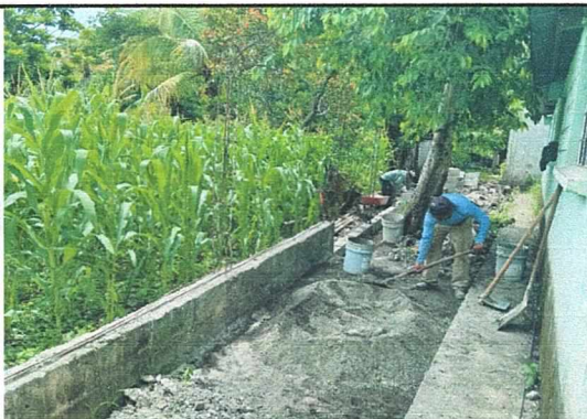
Foto 3: Reparación de muro perimetral.
