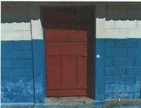
Foto 5: Reparacion de puerta y chapa
