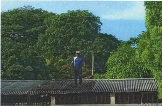
foto 1. Techo. Cambio de techo en las aulas
