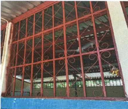
foto 3 reparacion de ventanas
