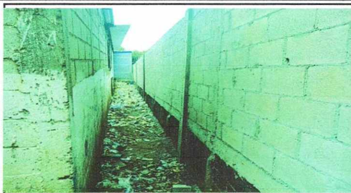
Foto 2: REPARACION DE MURO PERIMETRAL
