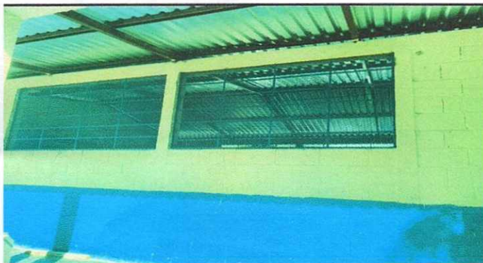
Foto 3: REPARACION DE VENTANAS
