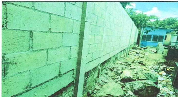
Foto 2:REPARACION DE MURO PERIMETRAL
