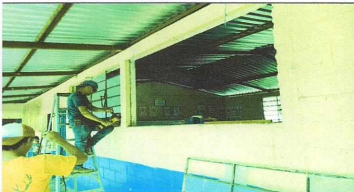
Foto 3: REPARACION DE VENTANAS
