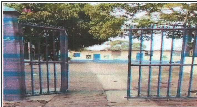
REPARACIÓN DE PORTÓN
