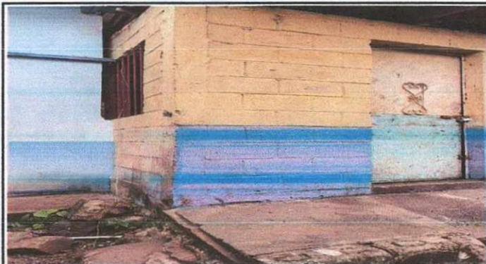
REPARACION DE COCINA
