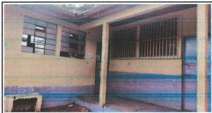
REPARACIÓN DE BENTANALES
