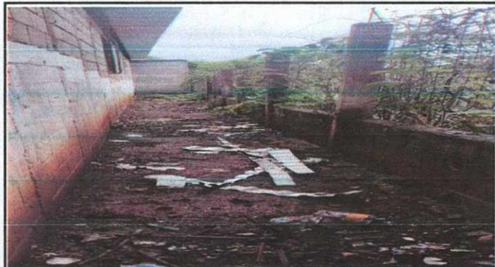
REPARACION MURO PERIMETRAL
