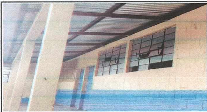
REPARACIÓN DE BENTANALES
