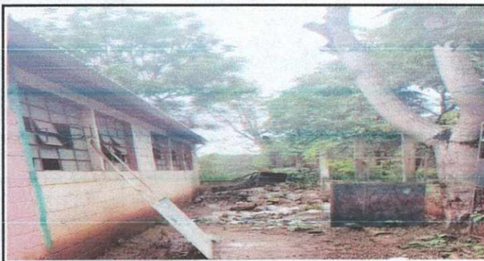
REPARACION MURO PERIMETRAL
