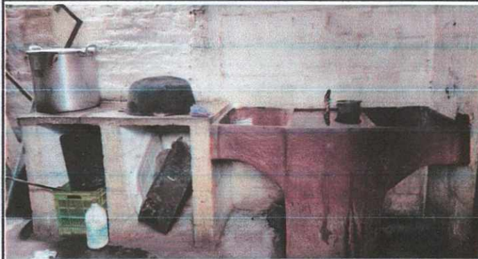
REPARACION DE COCINA
