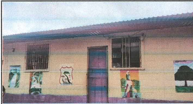
REPARACIÓN DE BENTANALES
