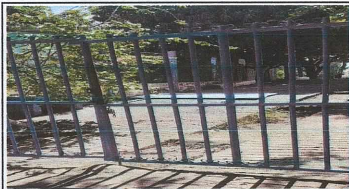
REPARACIÓN DE PORTÓN
