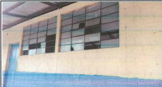
REPARACIÓN DE BENTANALES
