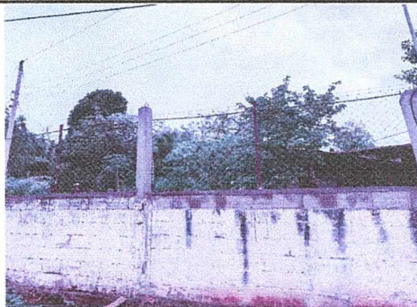
Foto 2. Cambio de maya del muro perimetral
