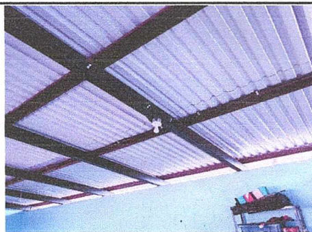
Foto 4. Sustitución de cubierta de lámina
