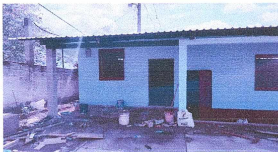
Foto 5. Pintura en paredes y puertas
