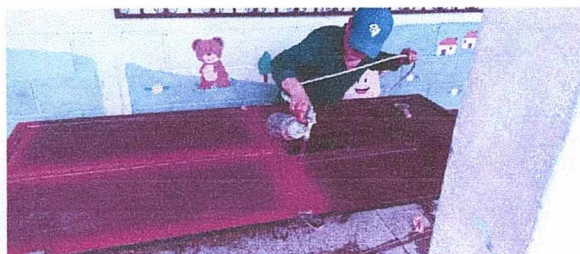
foto 5. Pintura en paredes y puertas
