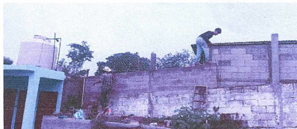
Foto 2. Cambio de maya del muro perimetral
