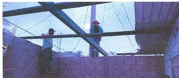
Foto 4. Sustitucion de cubierta de lamina
